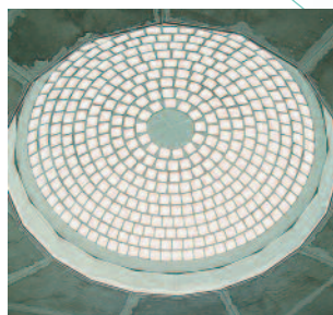
Maison d'arrêt (montage sur place) Arch in a public prison
